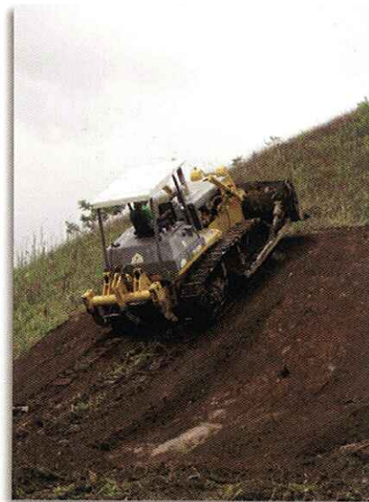
Movimiento de tierra y compactado
