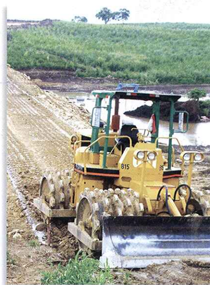
Movimiento y compactación de tierra.
