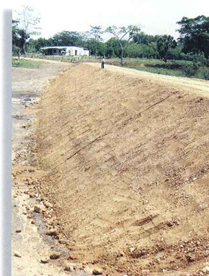
Muro de represa
